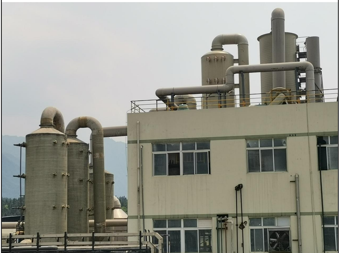
图 5 硫化氢吸收设施
