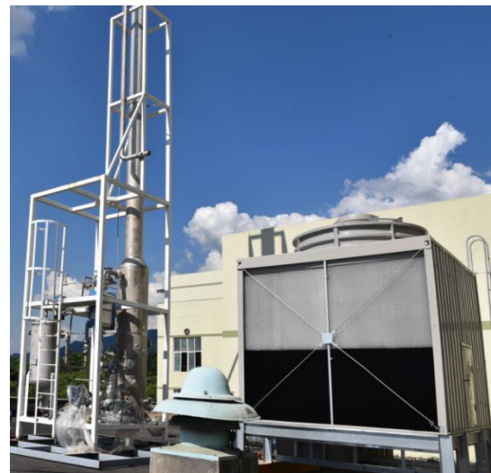
图 3 煅烧氨尾气回收
