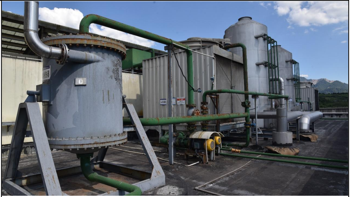
图 2 碱蒸汽回收设施
