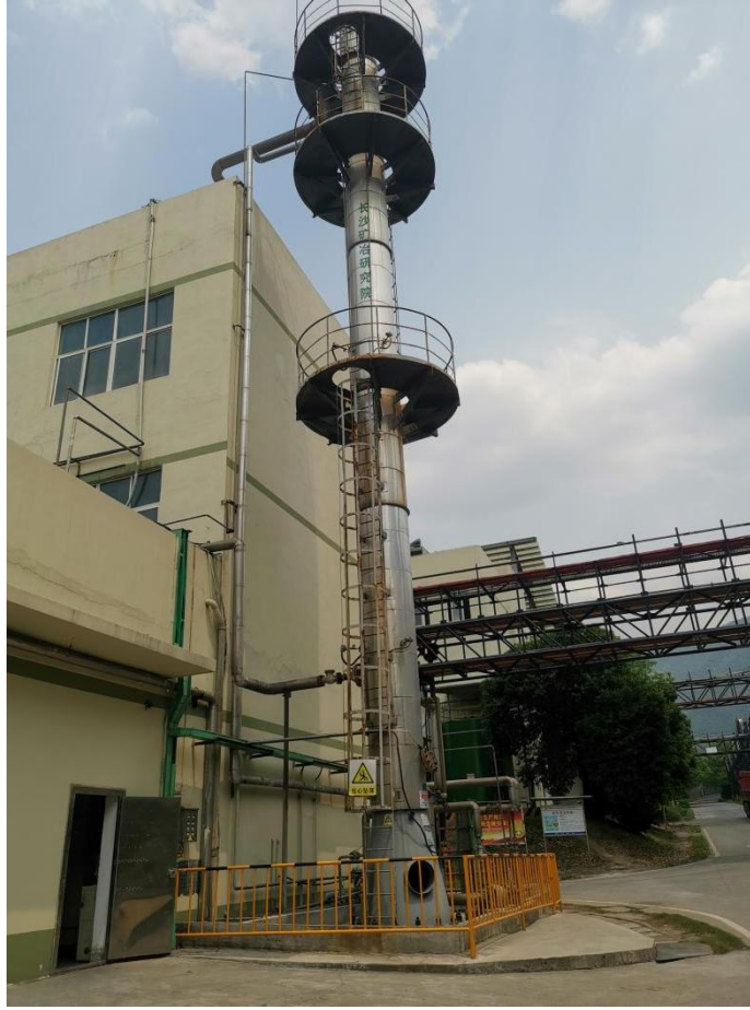
图 6 氨氮废水治理项目“汽提蒸氨”脱氨塔设施
